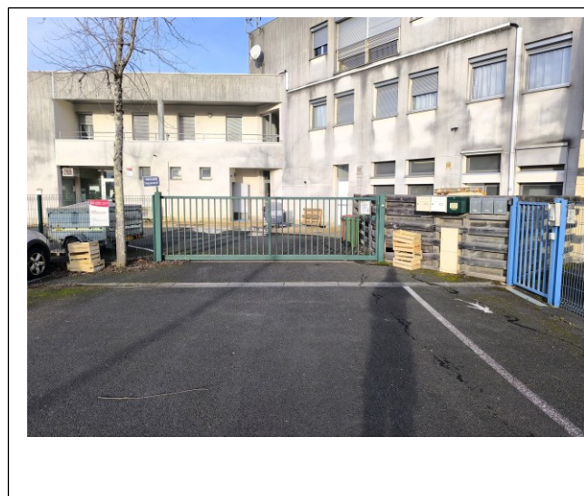
Portail Accès Pompiers Cuisines
