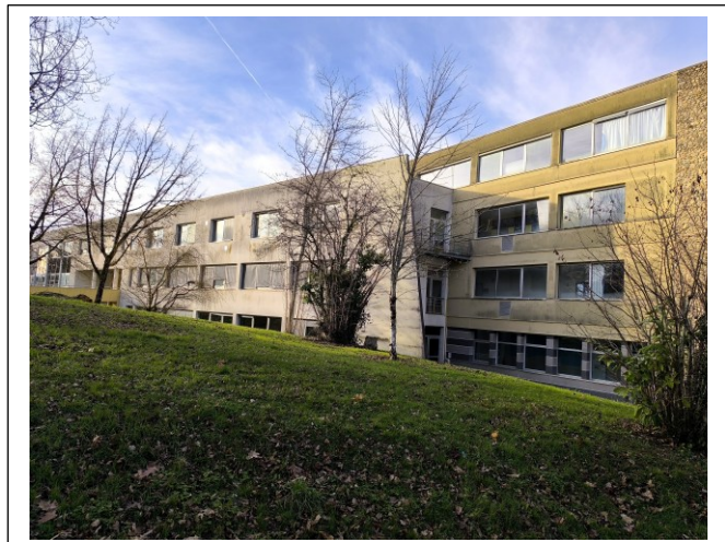
Façade Est côté Nord
