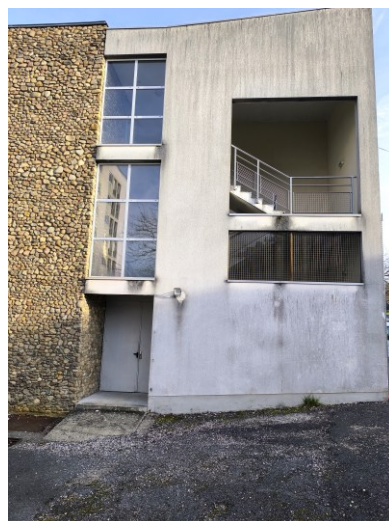
Façade Sud – Evacuation Internat
