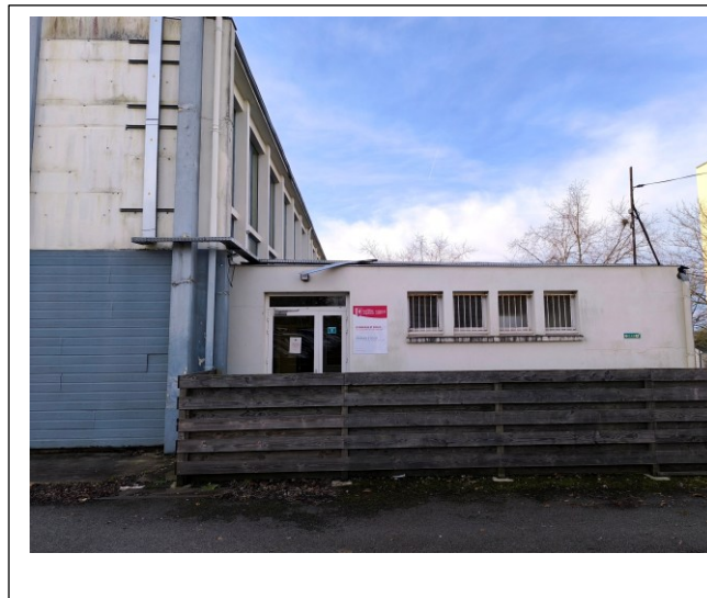
Entrée Gymnase Nord Vestiaires Filles
