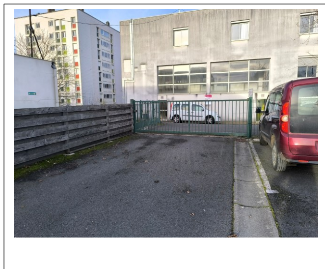
Portail Accès Pompiers Parking
