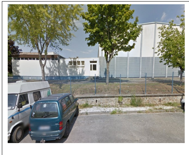
Entrée Gymnase Sud Vestiaires Garçons
